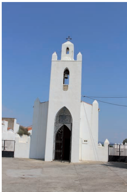
Detalle de la fachada de la ermita
