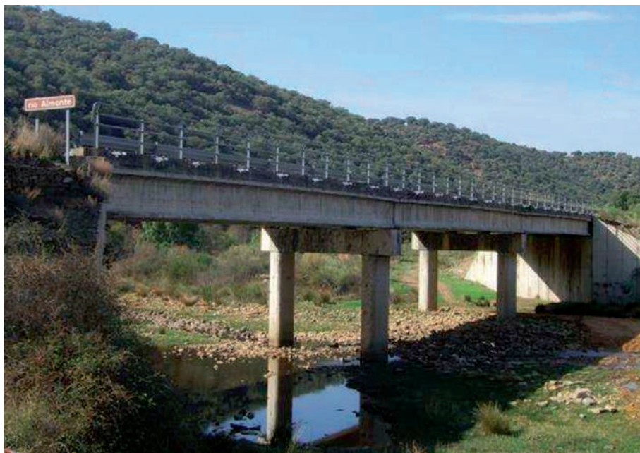
Puente moderno construido en la carretera entre Aldeacentenera y Retamosa.
