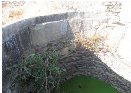
Detalle del interior
