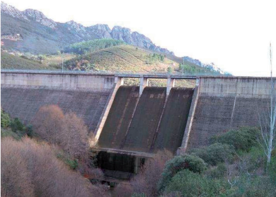
Presa de Santa Lucía
