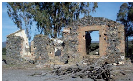
Pozo y casa de máquinas. Minas de San Roque
