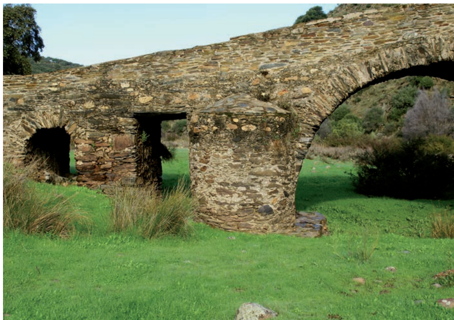
Aguas arriba, tajamar y aliviaderos, puente del Conde
