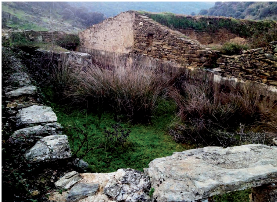
Restos del molino, Puente del Conde
