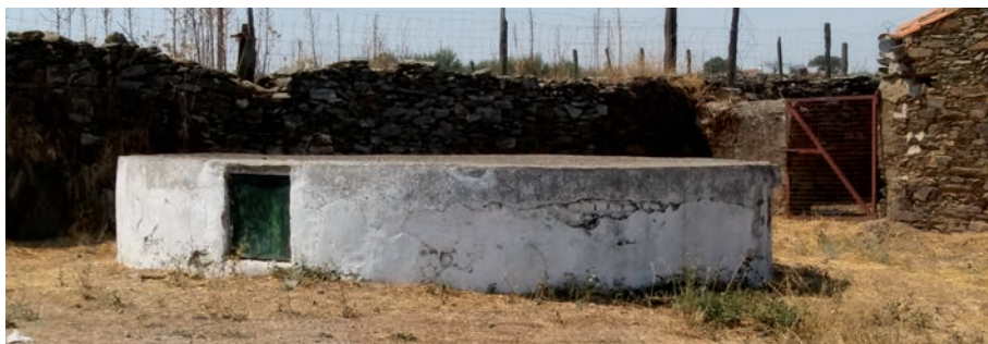
Pozo del cura, Ctra a Torrecillas
