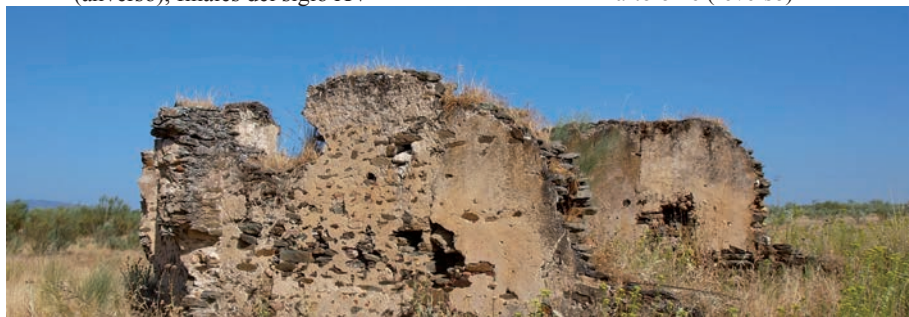
Restos de la iglesia del Ejido de Centenera
