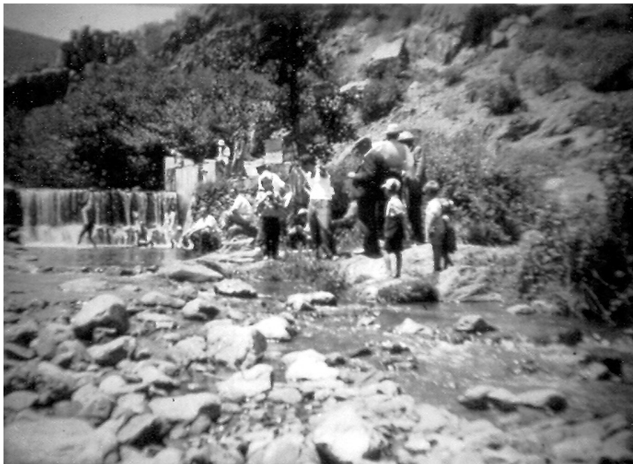
Toma de Agua de Santa Lucía, 1899.
