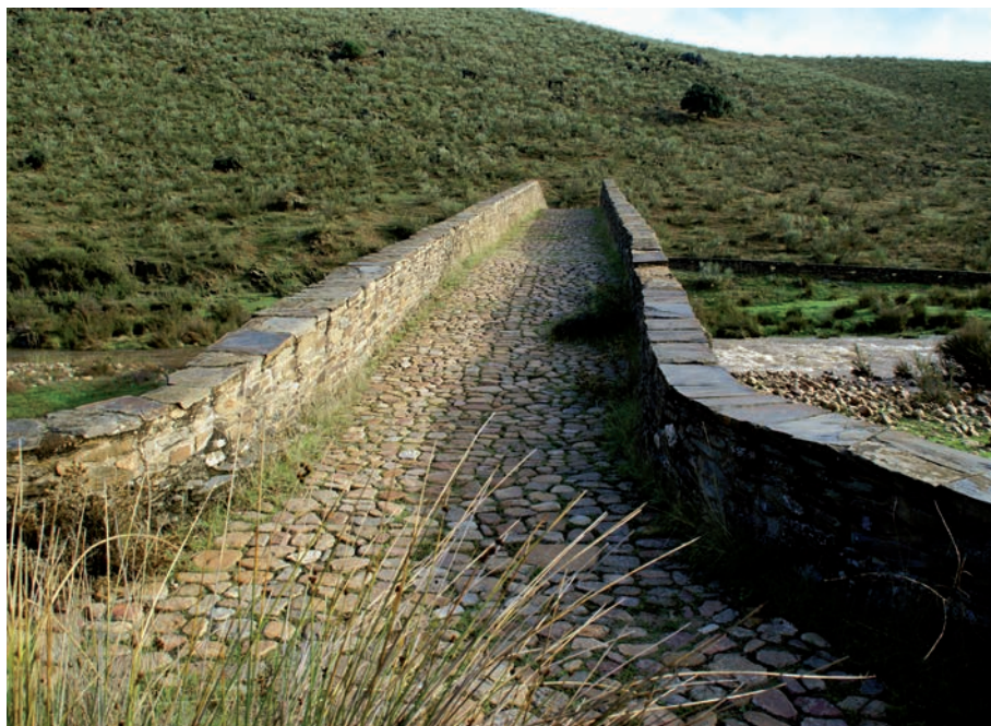
Detalle de la calzada
