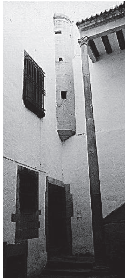
Interior del patio
