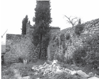
Restos de muralla (paramentos del edificio)
