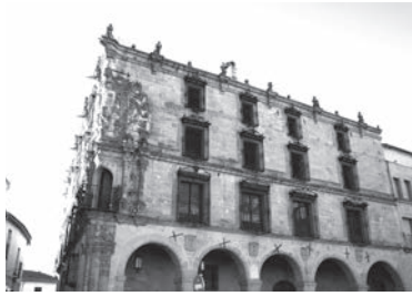
Vista general de la fachada septentrional
