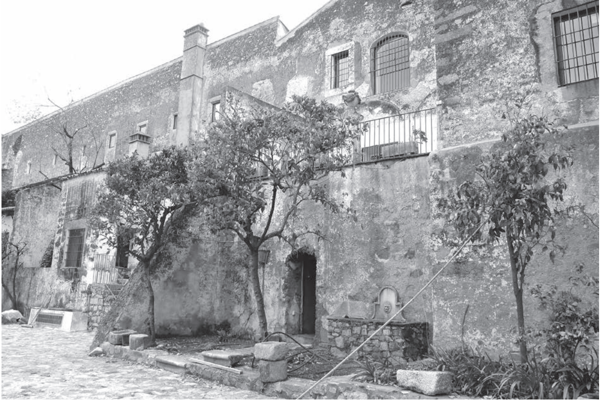
Zona septentrional del edificio
