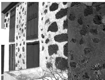
Casa donde estaba ubicada la tahona (Lomada Grande), 2008 [PCP]
