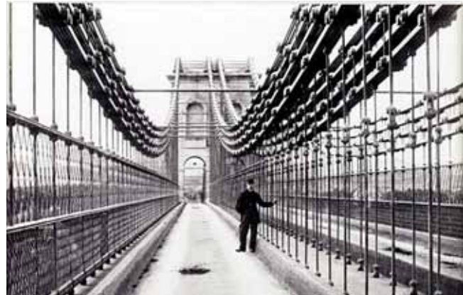
7. PUENTE DE MENAI: VISTA DE CONJUNTO (FUENTE: HISTORY-POINTS.ORG) Y SISTEMA DE SUSPENSIÓN.
