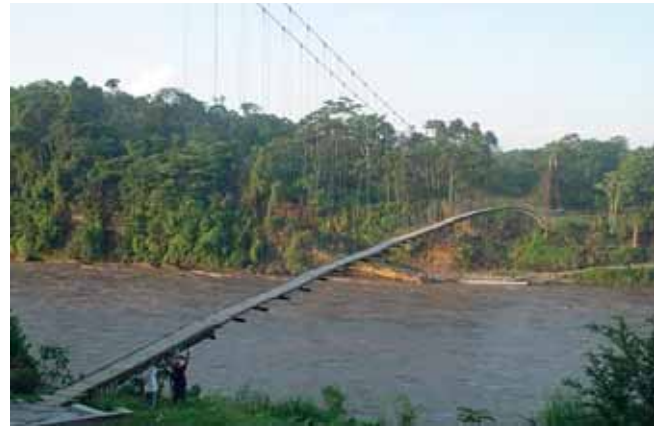
10. PUENTE COLGANTE PEATONAL Y ARTESANAL SOBRE EL RÍO AGUARICO (ECUADOR).
