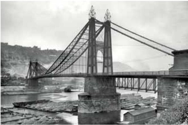
8. PUENTE DE PITTSBURGH.
