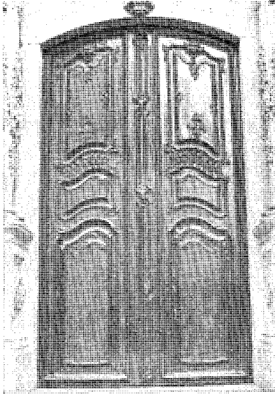
20. Puerta principal, vista exterior
