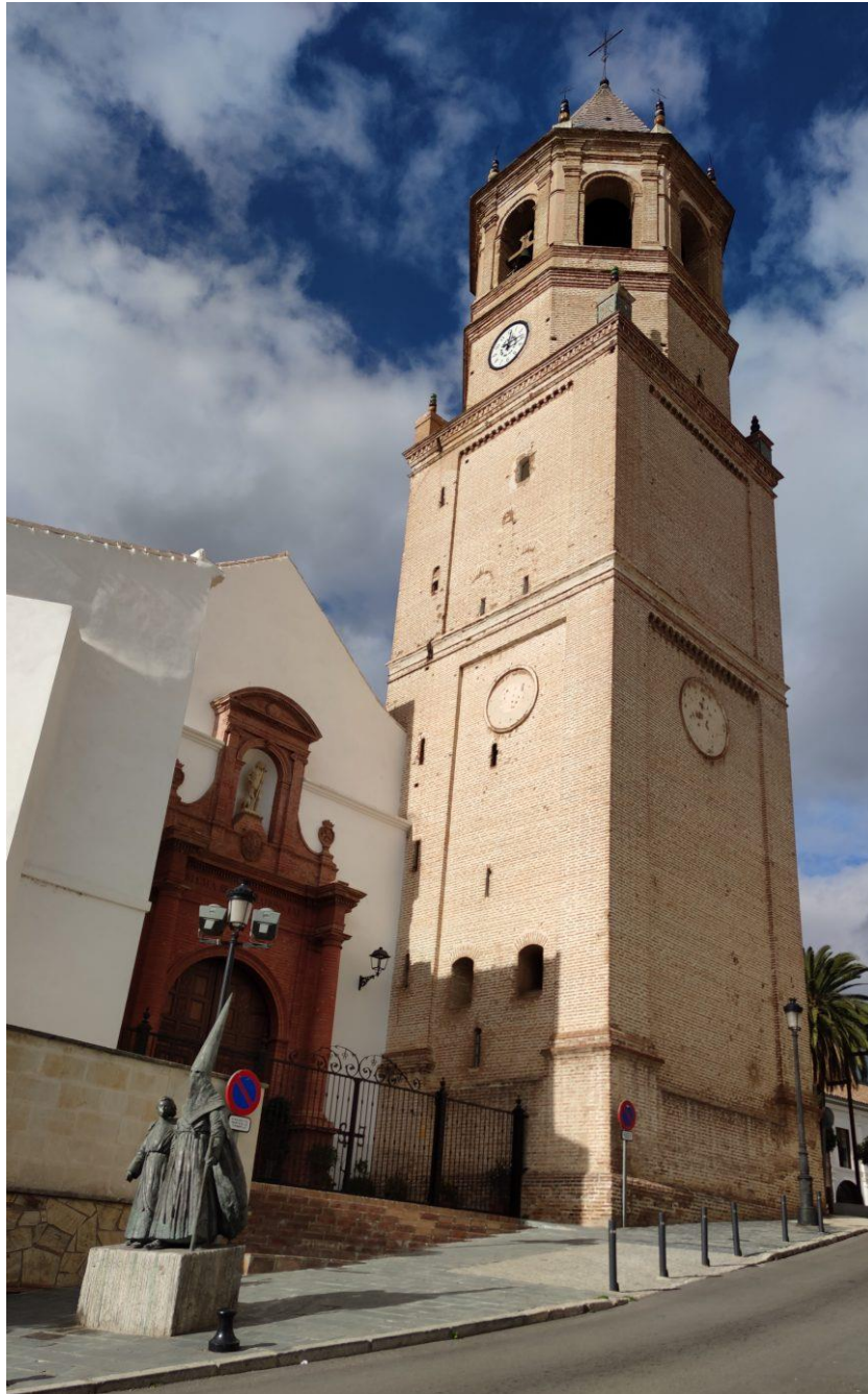
Fachada y torre de la Parroquia de San Juan Bautista de Vélez-Málaga, donde tuvo su sede la Real Congregación del Dulce Nombre de Jesús.
