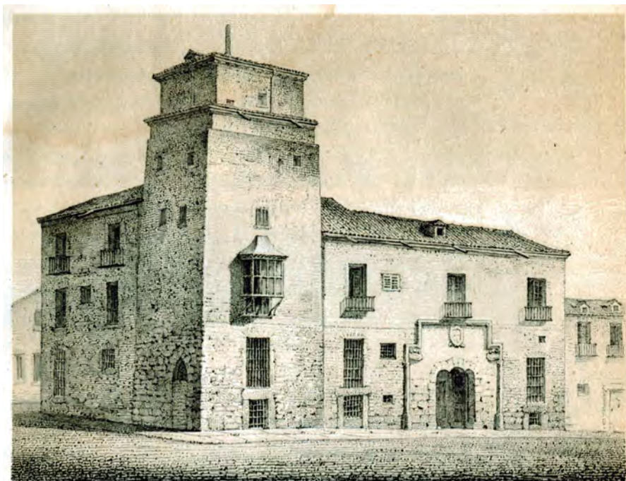
Casa y Torre de los Lujanes.
