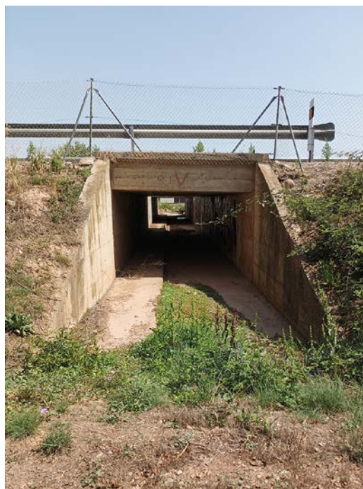
Figura 26. Paso ganadero bajo la autopista junto a la vereda de la Torrecilla. (Fotografía: J. L. Cinca).
