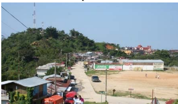
Foto 11. Cubiertas predomina la lámina
