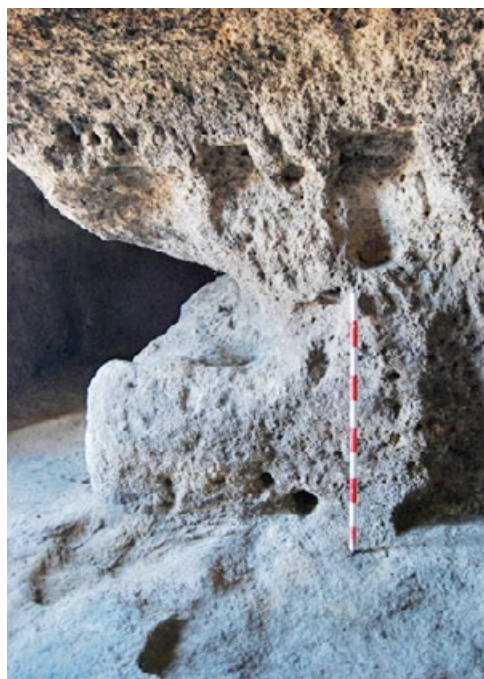
Figura 40. ER-2. Casetón y hornacina labrada en el acceso a la sala ER-2b. La similitud (coincidencia o no) de esta asociación con Arnedo es más que evidente
