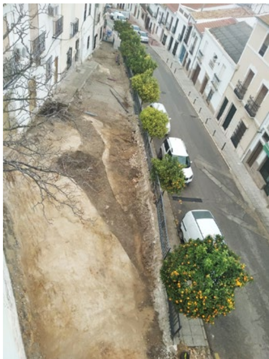
Figura 2. Vista general de la calle Enmedio en fase de obras. Alameda, 2019. Se observa el trazado del foso prehistórico y algunas afecciones de época posterior
