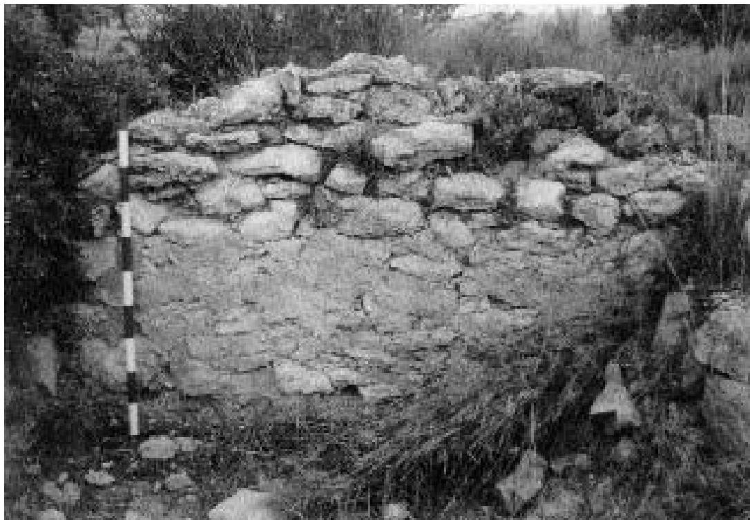
1.- Muro de mamposteria con enfoscado de mortero de cal.
