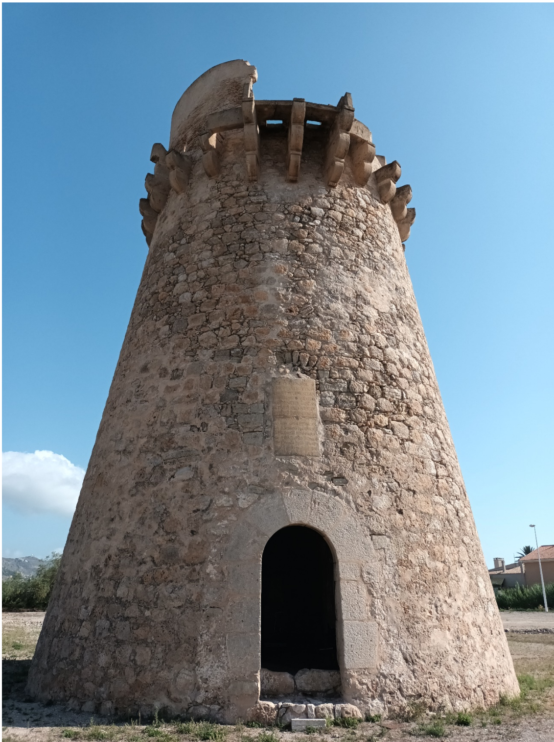
Torre del Marenyet, Cullera. Foto de Pascual Santos
