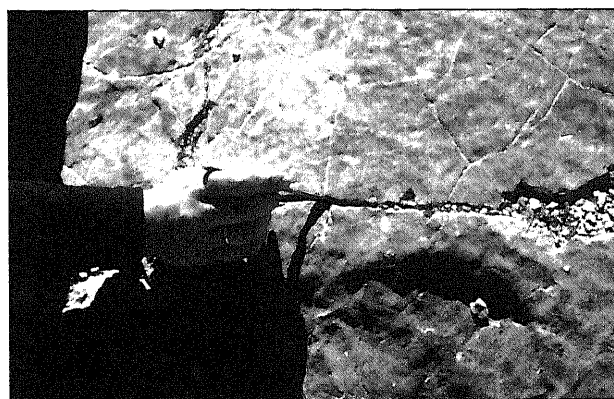
Fotografía 15. Restauración del yacimiento en los campos de trabajo. Limpieza de las grietas.
