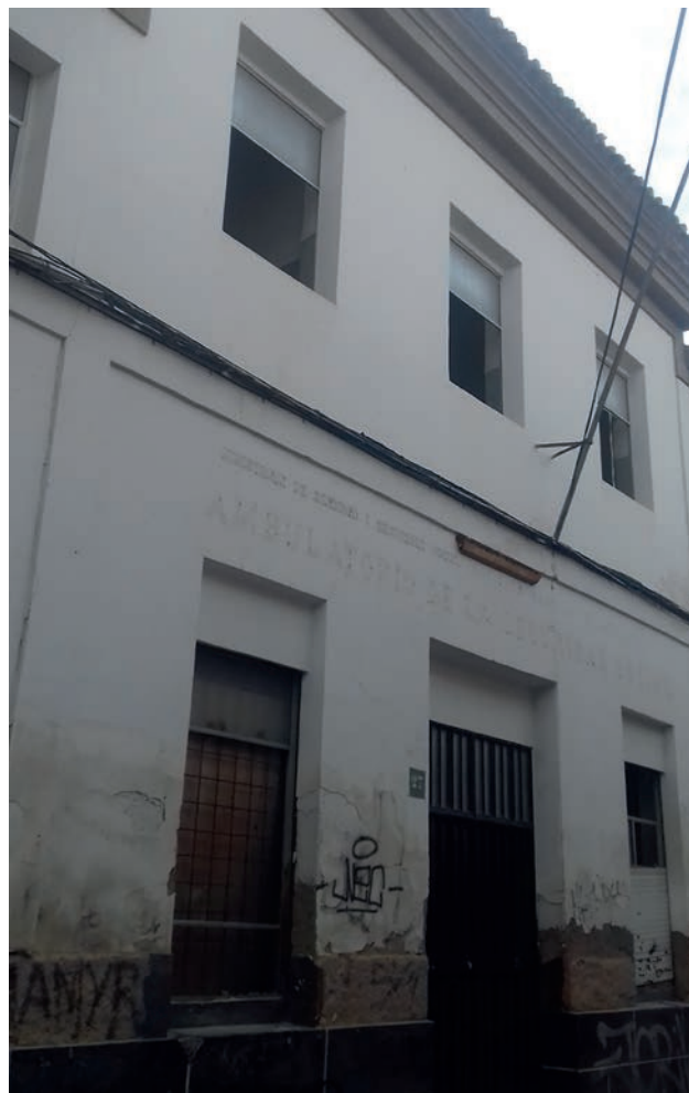
Fachada posterior del Ambulatorio previo a su demolición (2019). Calle Santa Gertrudis
