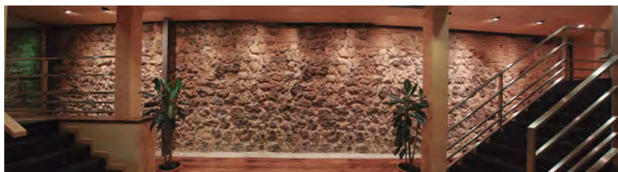
Vista del paño de la Muralla Cristiana. Siglo XII.
