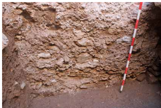
Figura 18. Vista detalle cimentación Mezquita
