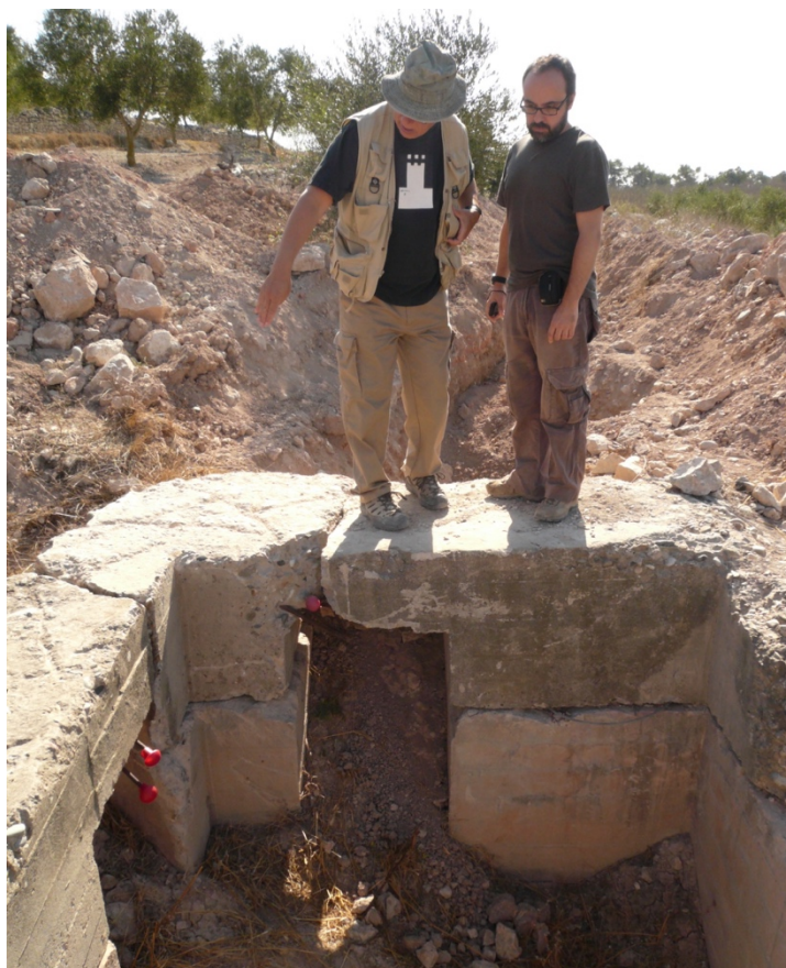
Figures 1, 2, 3. Fortí núm. 4 de Raïmats (la Fatarella). Restes conservades i en procés de reconstrucció (Lo Riu-Didpatri). Fotos: Didpatri.
