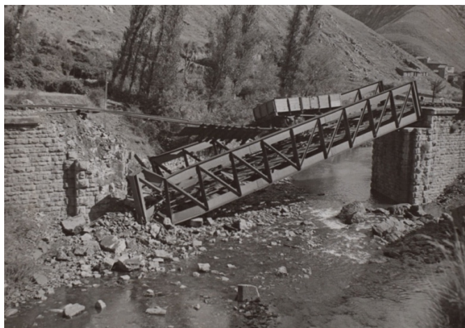
Figura 3. Puente de ferrocarril en Santa Lucía (León) volado por los republicanos. Biblioteca Nacional de España.
