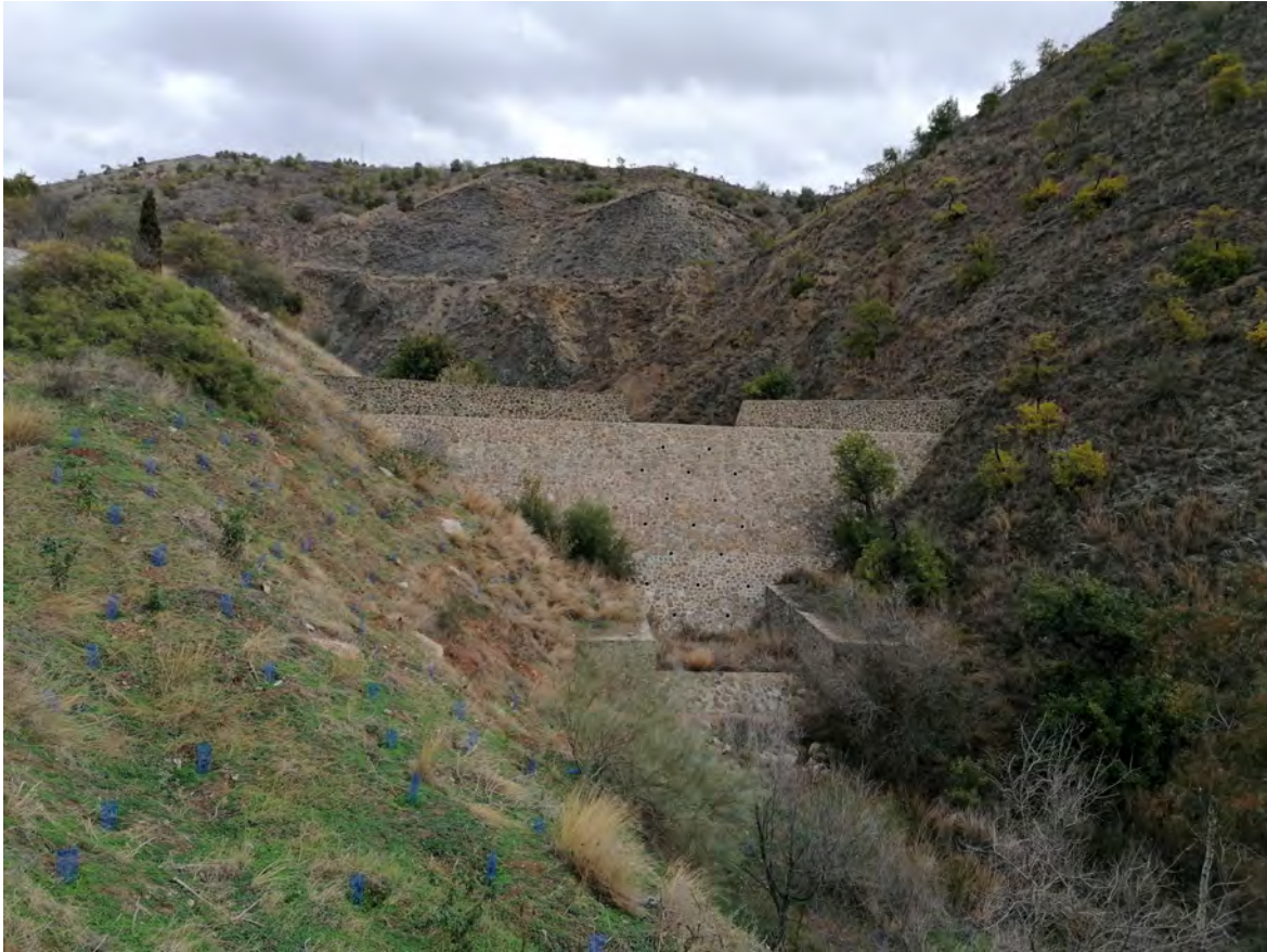
Figura 8. Dique de mampostería hidráulica.
