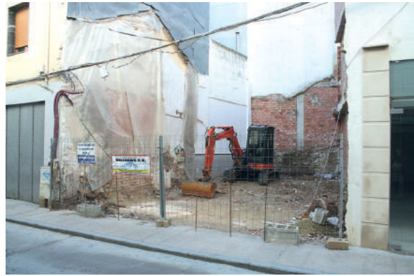
Fig. 2: Panorámica general del solar de c/ San Marcos nº 3 tras el derribo del inmueble y estado previo al raspado superficial y retirada de pavimentos de planta baja realizado en 2020.
