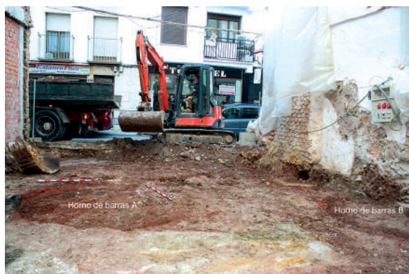
Fig. 5: Localización totalmente superficial, en 2020, de los hornos de barras A y B (HB-A y HB-B).
