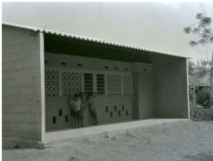
Construcción de la escuela de Los Gómez, foto de Jaime Arocha, junio-julio de 1964
