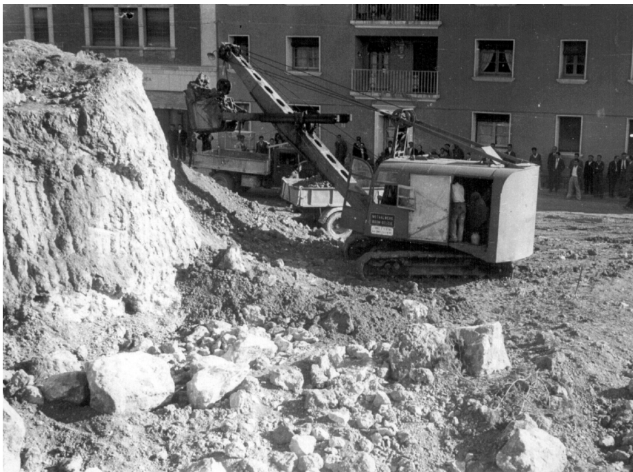
Obras de explanación para construir la Casa de la Cultura.
