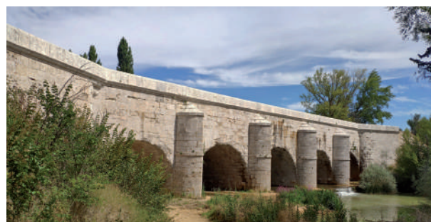
Figura 17. Vista, aguas abajo del Valdavia, del Acueducto de Abánades.
