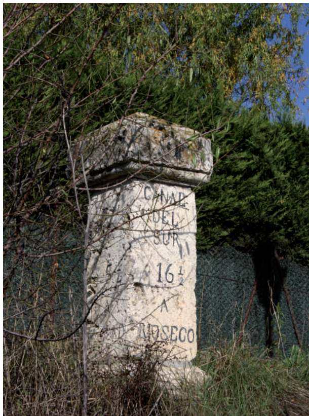
Figura 8. Leguario en el ramal Sur en Dueñas.
