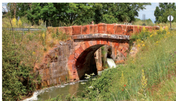
Figura 13. Puente de la esclusa 10 en Castrillo de Riopisuerga.
