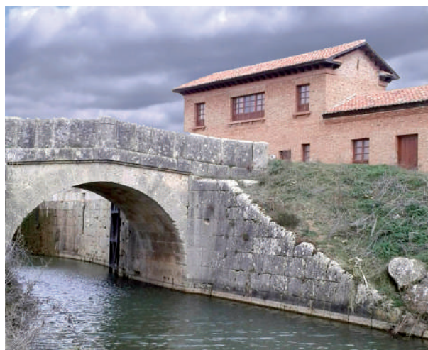
Figura 14. El puente y la casa del esclusero de la esclusa 14 en San Llorente de la Vega.
