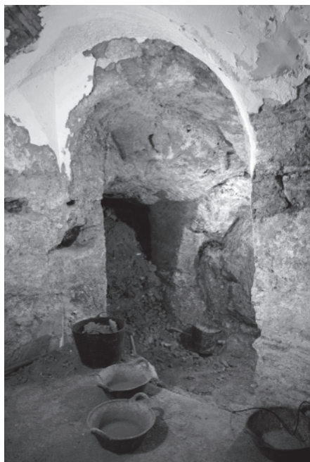
C/ Carrera de las Monjas, 16. Bodega. Mina reabierta del espacio molinero y que se hallaba totalmente condenada.
