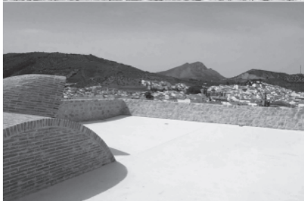
Torre del homenaje. Comparativa del terrado, con eliminación de cubierta de teja.
