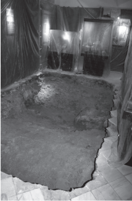
Sala IV del Museo en proceso de rehabilitación urgente.
