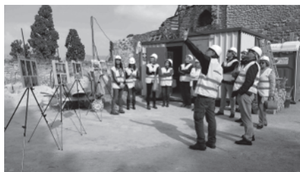
Visitas guiadas al castillo durante las obras de consolidación de la torre del homenaje.
