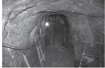
C/ Carrera de las Monjas, 16. Bodega. Mina excavada en el travertino asociada al uso molinero del espacio.
