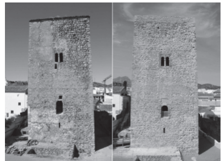
Torre del homenaje. Comparativa de la intervención.
