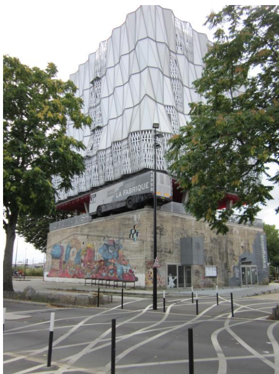
Fig. 03. Sede de La fabrique laboratoire(s) artistique(s) en el Boulevard de la Prairie au Duc. Además de los murales pintados en las fachadas, se ve pintada en el suelo la obra 'Traverses' de Aurélien Bory. Foto: Natalia Juan.
