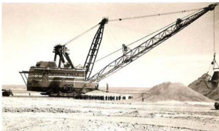
Figura 5. La dragalina destinada al desmonte previo en la explotación de Bucraa.
