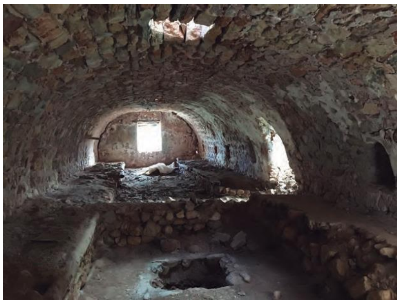
Fig. 14. Bóveda para trabajadores en Santo Antolino
