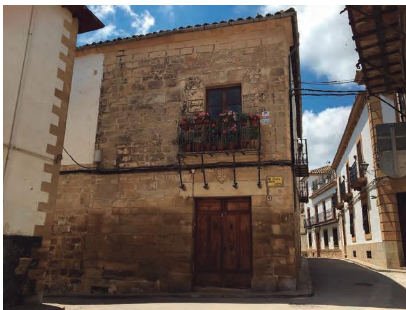
Fig. 10. Casa Solar del siglo XVIII de la familia Pasquau que se extiende por las calles García Pretel y Andújar en la ciudad de Úbeda
