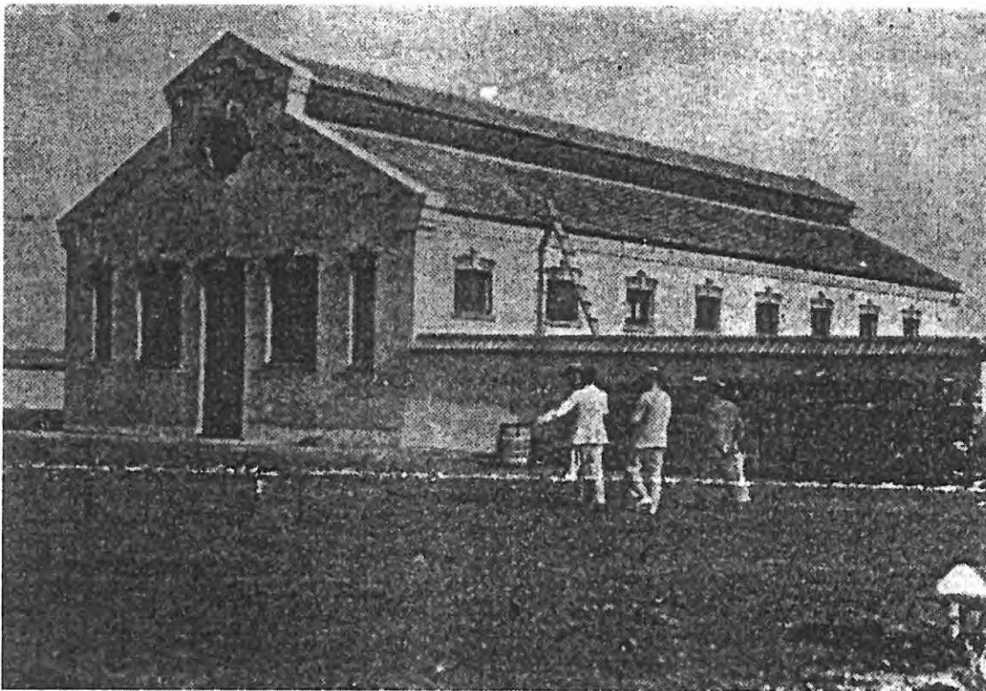
7.- Nave de establos del nuevo Matadero diseñado por el Arquitecto Fernando Guerrero Strachan en 1924-1937, en las proximidades de la barriada de Carranque.
