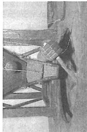
4.- Mano de hierro para regular la caída del grano. Molino Morisco de Alhaurín
