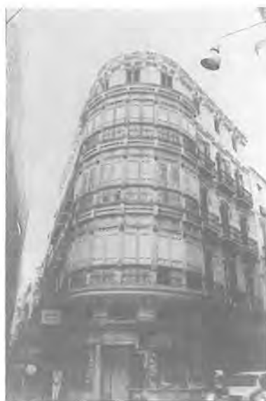
15. Edificio de viviendas en C/. M. Larios esquina a Sta. María.
