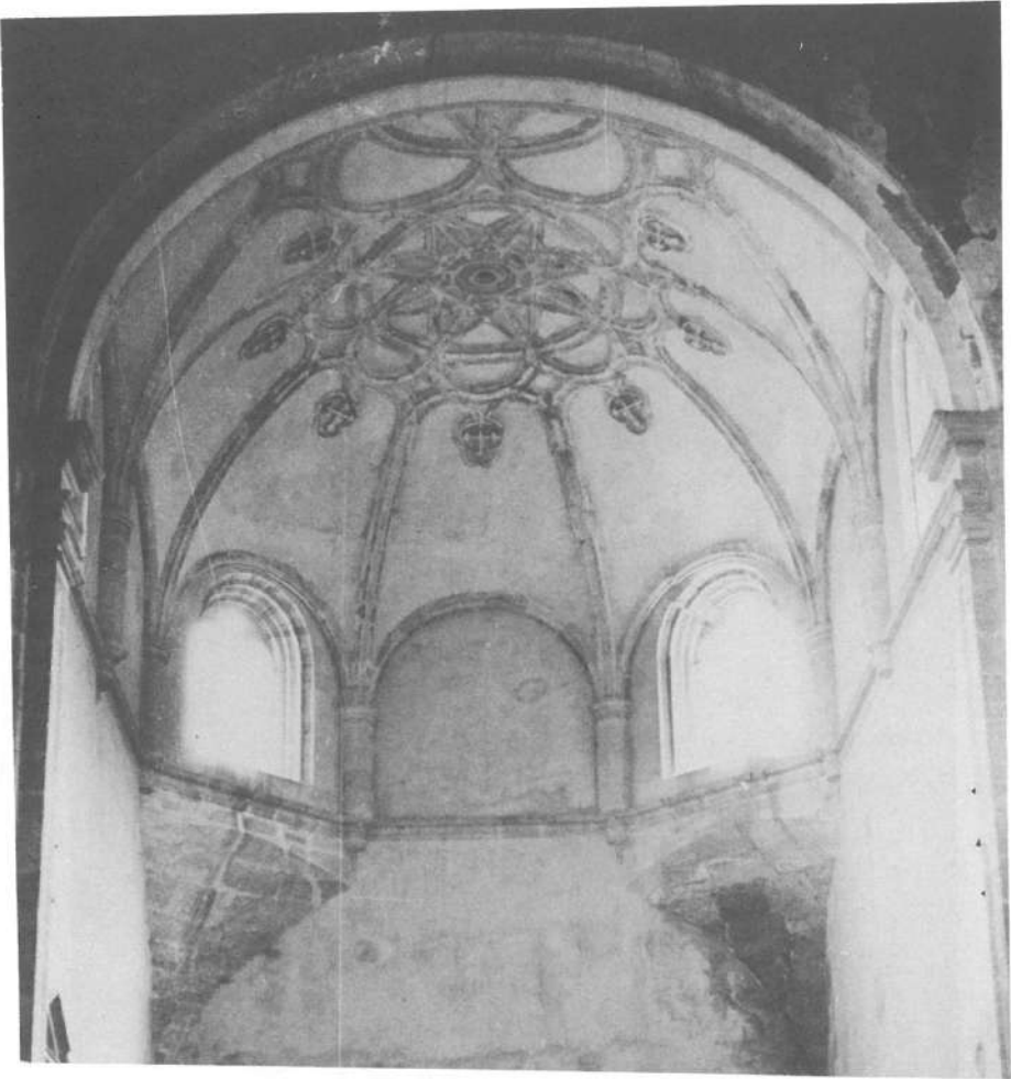
Lám. 2.— Colegiata de Santa María. Bóveda nervada de la cabecera. Diego de Vergara.
