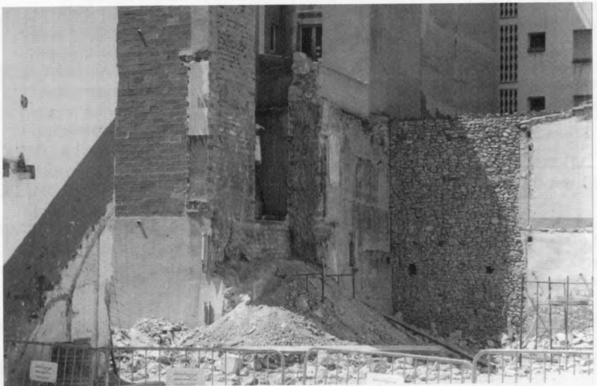
2. Estat del solar de l'Hospital just abans de la intervenció arqueològica. Observi's el desmunt parcial de la muralla. Foto Josep Maria Sabaté
