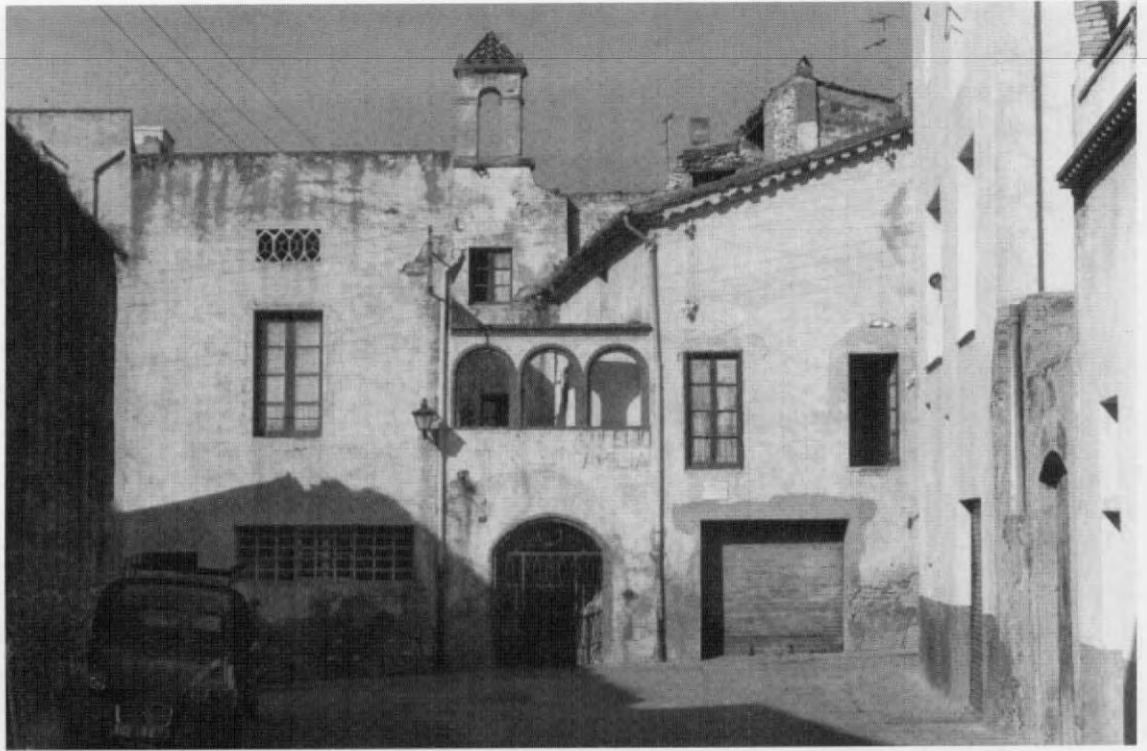
5. Vista de l'edifici de l'antic Hospital de les Monges, any 1975. Foto Josep Maria Sabaté
