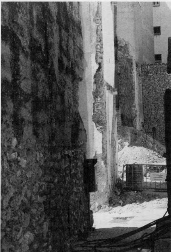
4. Vista de la muralla abans de la intervenció. Al fons, el desmunt parcial del parament. També es pot veure la perfecta aliniació del llenç a l'Hospital amb el de la plaça adjacent. Foto Josep Maria Sabaté.
