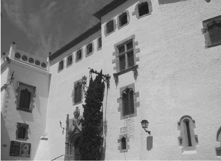
Fig.4. Façana del Palau de Maricel on s'aprecia una les finestres de la planta noble i les petites finestres de la façana sud del castell de Solivella (Fotografia: Sebastià Sánchez Sauleda).
