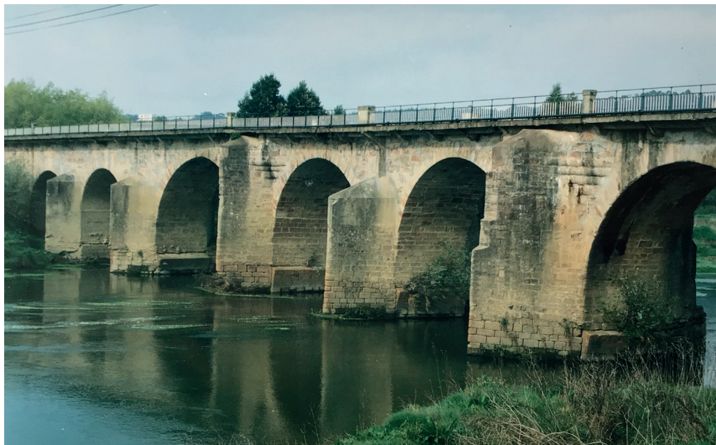
Fig. 4 – Arcos A4 a A9, vistos de nordeste, em 1999 (fotografia do autor); actualmente, falta o pilar P7, entre A7 e A8.
