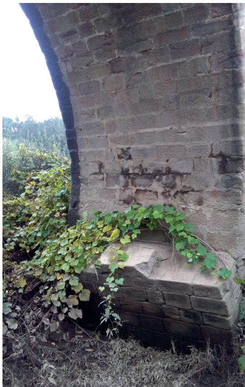
Fig. 3 – Intradorso de arco da ponte actual e arranque de arco da ponte medieval em P9A10.
