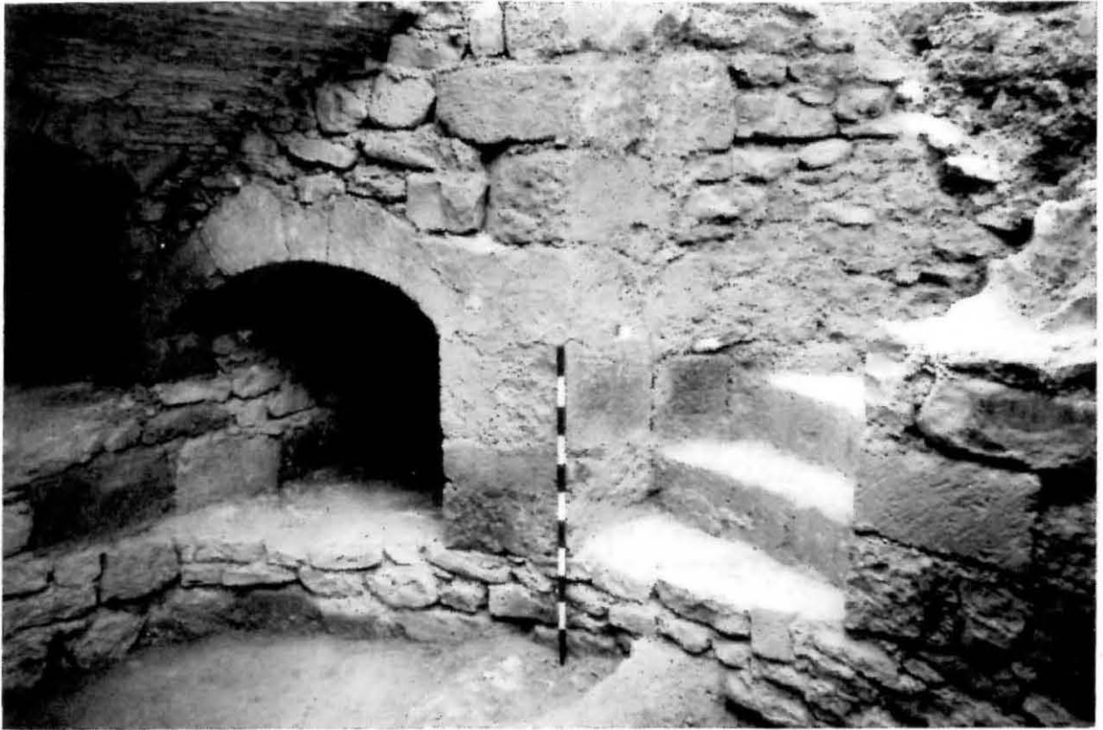
FIGURA 8. Detall del sòcol, de les escales i d'una de les espitlleres del balaurd (foto Enfoc)
