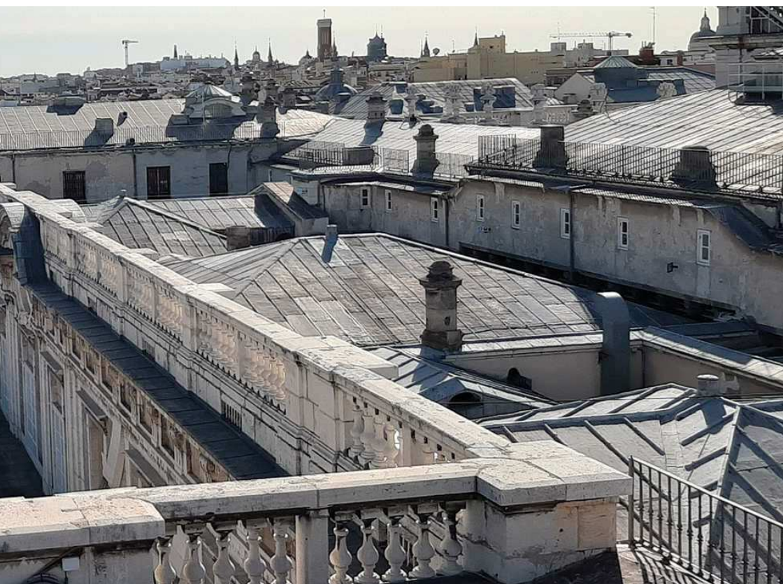
Detalle de los tejados y terraza del Palacio Real en la actualidad. Fotografía del autor.
