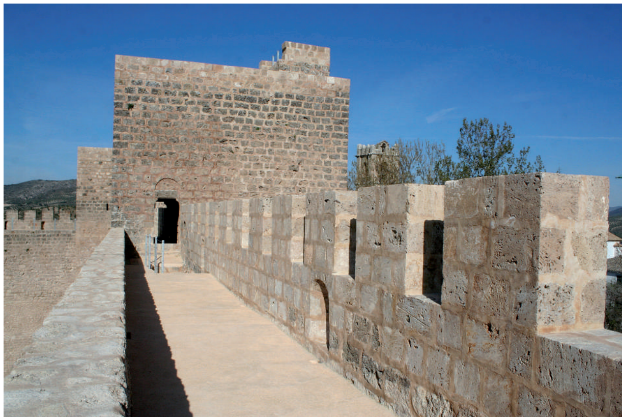
Fig. 30: Lienzo 1. Adarve, estado final. Al fondo, la entrada a la Torre 2.
