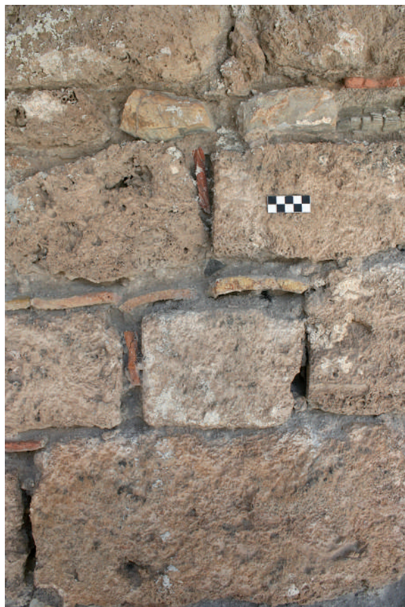
Fig. 38: Ejemplo de estereotomía descuidada en el corte y colocación de la sillería, con desnivelaciones y recalces abundantes. Su empleo estaba destinado a sectores menos visibles de la obra. En todo caso, el rejuntado tendía a regularizar el grosero aspecto original, ahora evidenciado por erosión de los morteros. Lienzo 2, interior, parte superior de la muralla.
