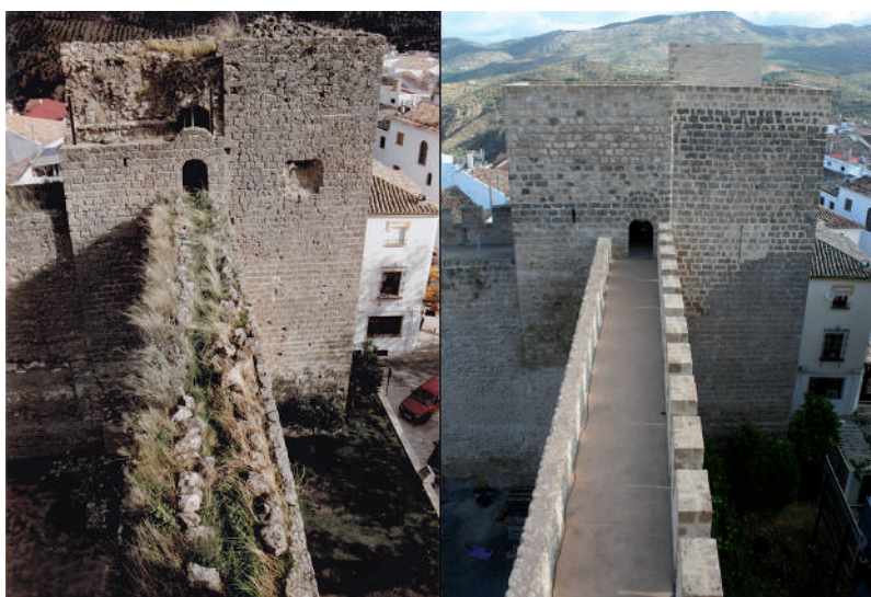
Fig. 27: Lienzo 2 y Torre 3 en un estado anterior y posterior a la actuación de 2019-2020, representativo del calado de la intervención.
