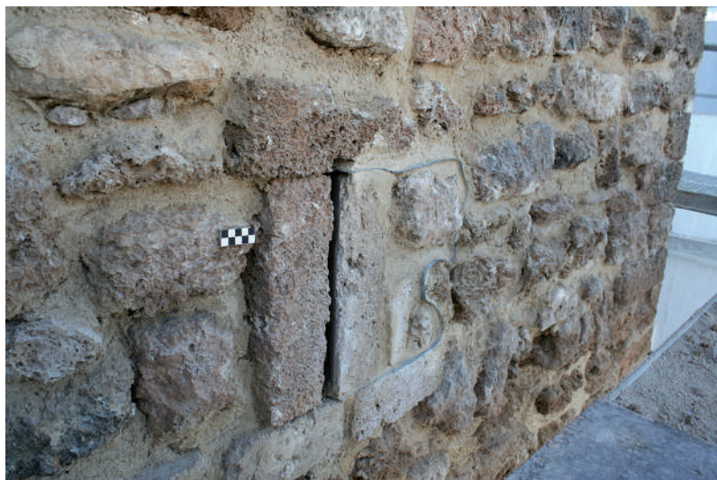
Fig. 85: Torre 7, lado a. Aspillera en proceso de reintegración formal, prueba de la existencia de una cámara interior amortizada durante la construcción de la Torre 1, que la parasita.
