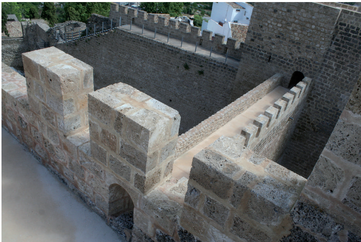
Fig. 28: Perspectiva general desde la terraza de la Torre 2 orientada hacia el Lienzo 2 y la Torre 3. Estado final.
