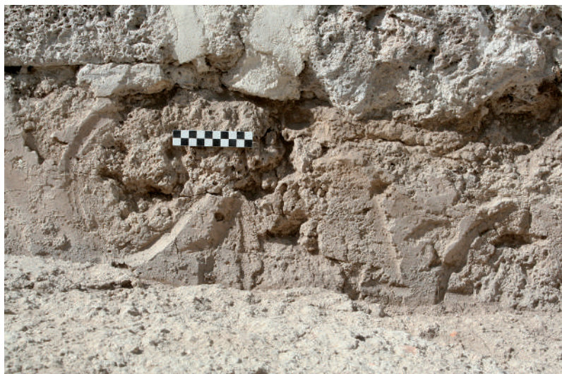
Fig. 47: Rejuntado, a modo de envitolado (U.E. 51), de la mampostería y sillarejos empleados en la construcción del paradós del Lienzo 1, en su lado orientado al adarve.
