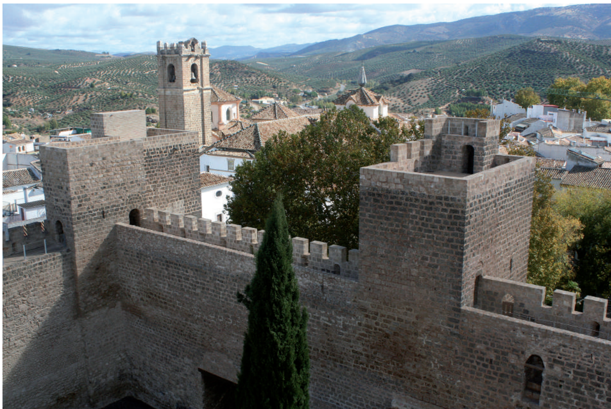
Fig. 29: Panorámica general parcial desde la terraza de la Torre del Homenaje. Estado final, hacia las Torres 3 (izquierda) y 2.
