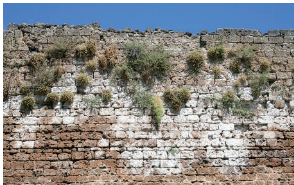
Fig. 25: Lienzo 1, exterior. Ejemplo de afección grave por sales cristalizadas. Fotografía de 2010.
