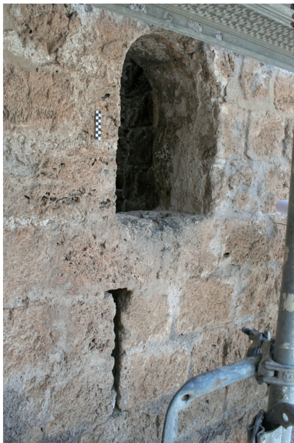
Fig. 22: Torre 3, sector ampliación. Ventana y aspillera originales. La ventana se conforma aprovechando el espacio entre dos merlones de una fase constructiva previa del Lienzo 3.
