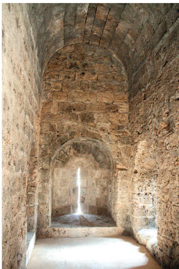
Fig. 15: Torre 2. Interior, con el volumen original de las cámaras de tiro recuperadas tras los trabajos de 2019-2020.
