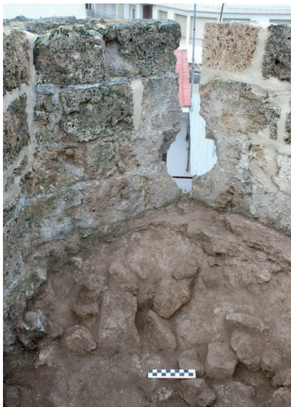
Fig. 82: Torre 1. Cámara de tiro D en proceso de reexcavación y limpieza. Se observa el acondicionamiento pirobalístico de la aspillera, la plataforma original parcialmente desmantelada y restos de dos pavimentos superpuestos, el original fundacional, de cal, y otro de yeso postmedieval.
