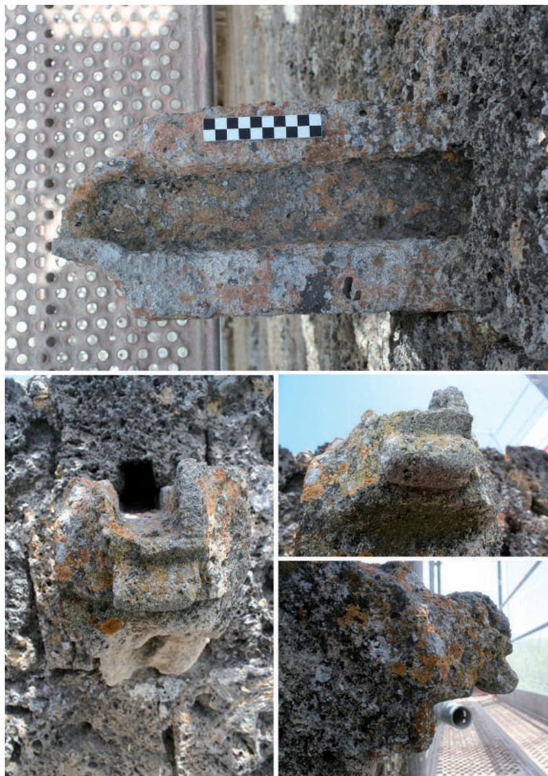
Fig. 66: Torre 3, lado a, exterior. Gárgola. Es el ejemplar mejor conservado, a excepción de la decoración de la parte inferior de su vuelo, prácticamente desaparecida.
