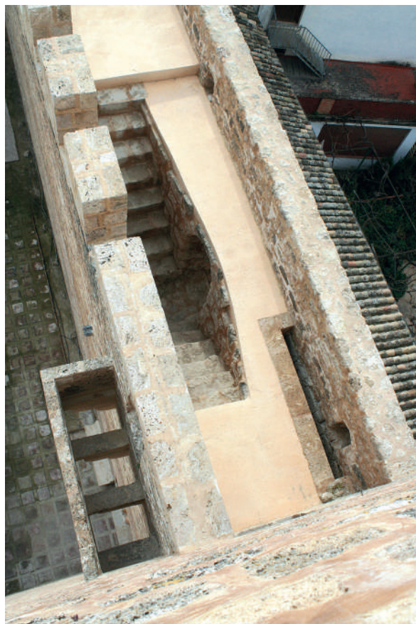
Fig. 12: Detalle del extremo del Lienzo 1 que entesta con la Torre 2, a la finalización de los trabajos de 2019-2020. De izquierda a derecha: ladronera, parapeto aspillerado con merlatura, escalera doble, ranura del rastrillo y paradós aspillerado.
