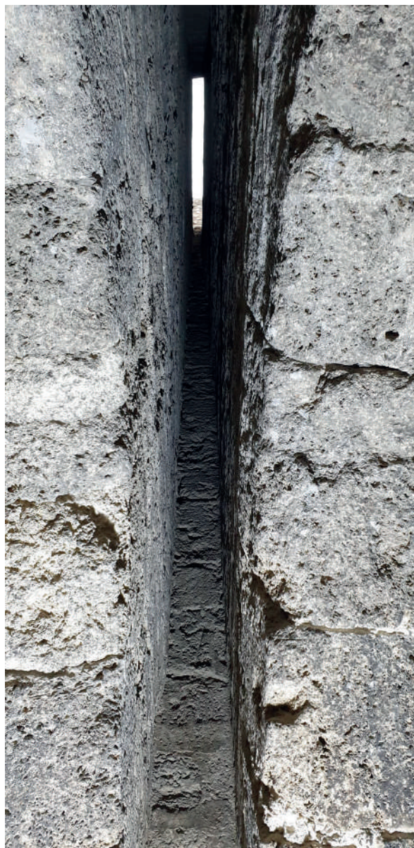
Fig. 11: Detalle del interior de la mortaja o ranura del rastrillo, vista desde abajo, tras su limpieza y desescombro. Fuente: Construcciones Medina Bahiga.
