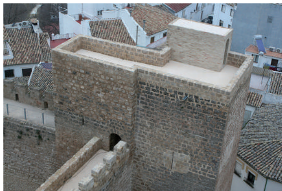
Fig. 20: Torre 3, unida a los Lienzos 2 y 3. Panorámica general al término de los trabajos.
