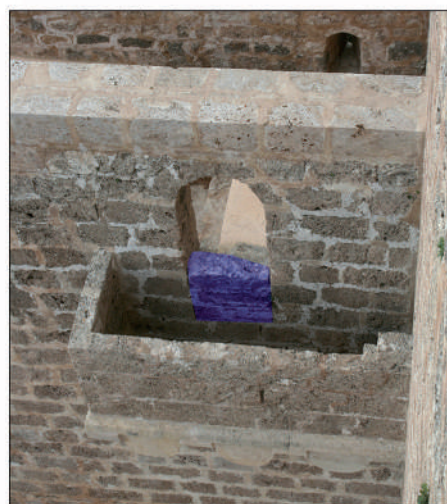
Fig. 73: Ladronera (Lienzo 1). Secciones proyectadas con indicación de las dos fases constructivas documentadas (A y B). En la fotografía derecha la refacción correspondiente a la Fase B está señalada en color.
