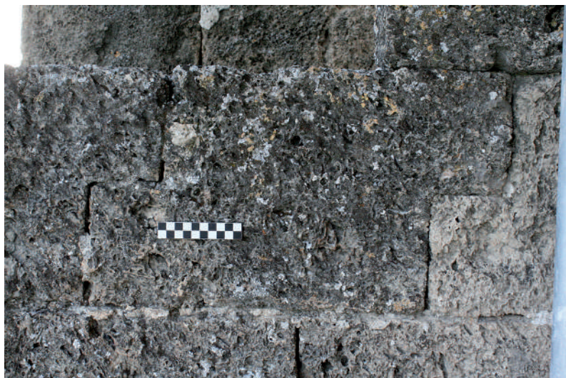
Fig. 71: Ladroneira (Lienzo 1). Detalle de la sillería engatillada de su parapeto.
