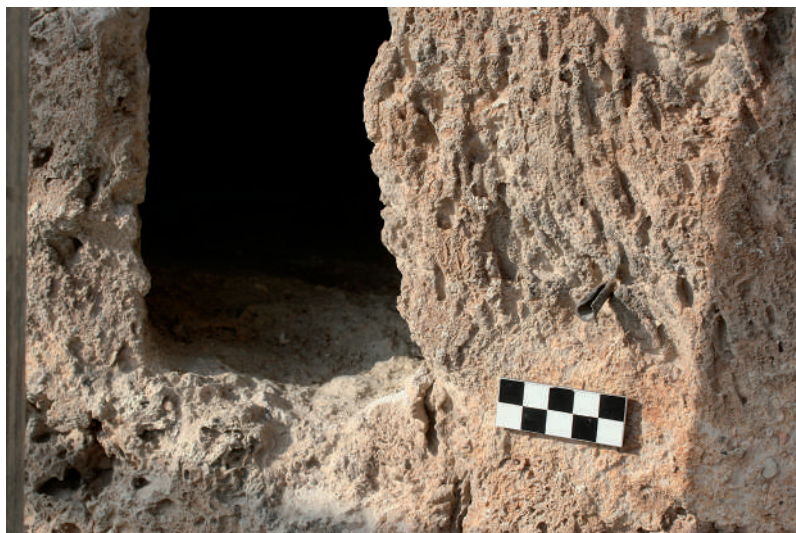
Fig. 110: Punta nº 2. Torre 3, lado c. A la izquierda, aspillera de la Cámara de tiro B.
