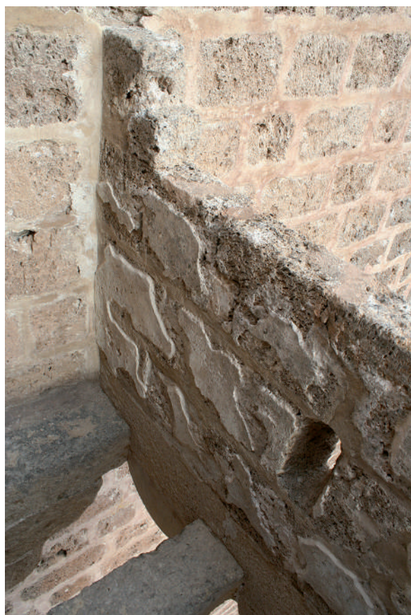
Fig. 72: Ladroneira (Lienzo 1). Detalle del enlucido original interior con mortero de cal, tras su limpieza y consolidación.
