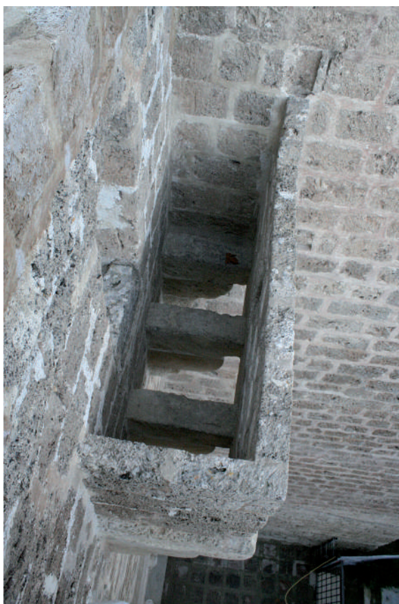
Fig. 70: Ladroneira (Lienzo 1). Detalle de las ménsulas que sostienen la caja defensiva.
