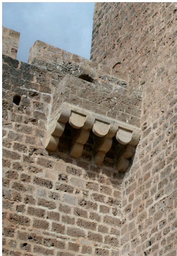
Fig. 69: Ladroneira (Lienzo 1). Estado final.
