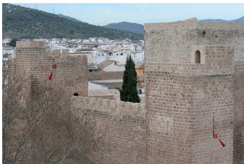
Fig. 116: Los impactos de proyectiles conservados tienden a ubicarse, de manera previsible, en las proximidades de parapetos y aspilleras. Dos casos paradigmáticos son las puntas nº 1 y nº 2.
