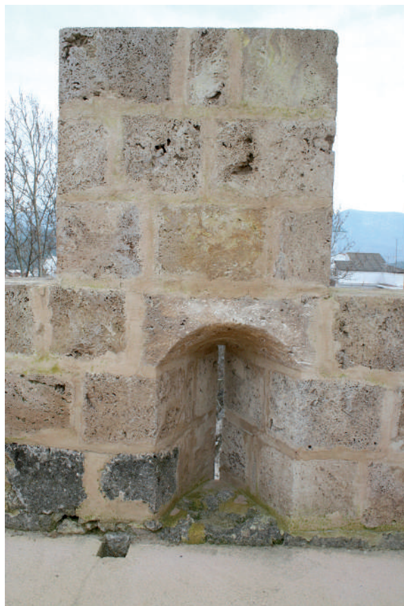
Fig. 19: Torre 2. Adarve. Ejemplo de parapeto, aspillera y merlatura recuperados conforme al registro arqueológico documentado.
