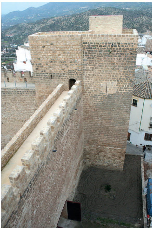
Fig. 18: Lienzo 2, que une las Torres 2 y 3 (en la foto), en un momento muy avanzado de las obras.
