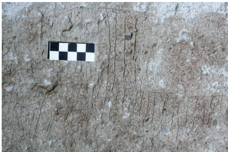
Fig. 104: Torre 3, interior, Cámara de tiro B. Marcas de contabilidad sobre enlucido de yeso (siglos XIX-XX)
