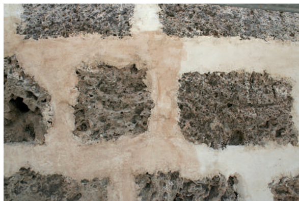
Fig. 36: Rejuntado de mortero de cal empleado en los trabajos de restauración, a imitación del original medieval. Incluye entonación cromática. Lienzo 1, exterior.
