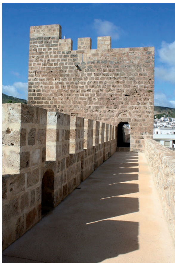
Fig. 31: Lienzo 2. Adarve, estado final. Al fondo, entrada a la Torre 2.
