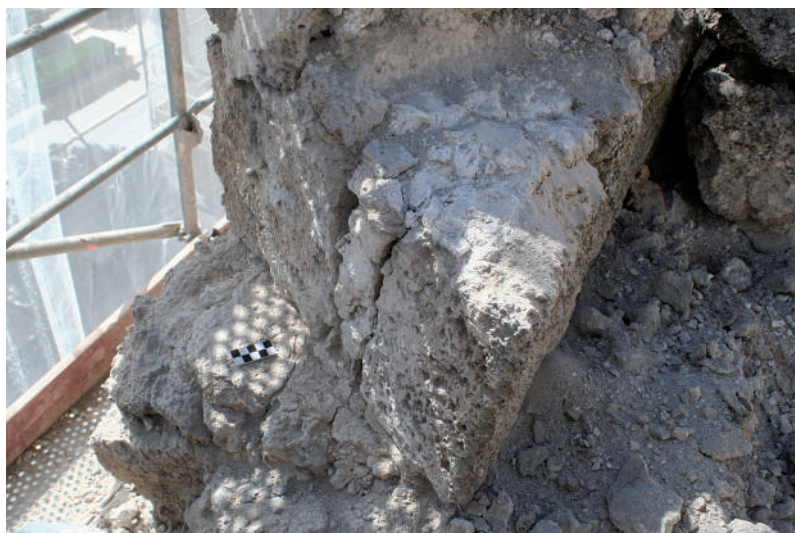
Fig. 54: Lienzo 1, parapeto, aspilleras 3, en curso de limpieza y documentación.
