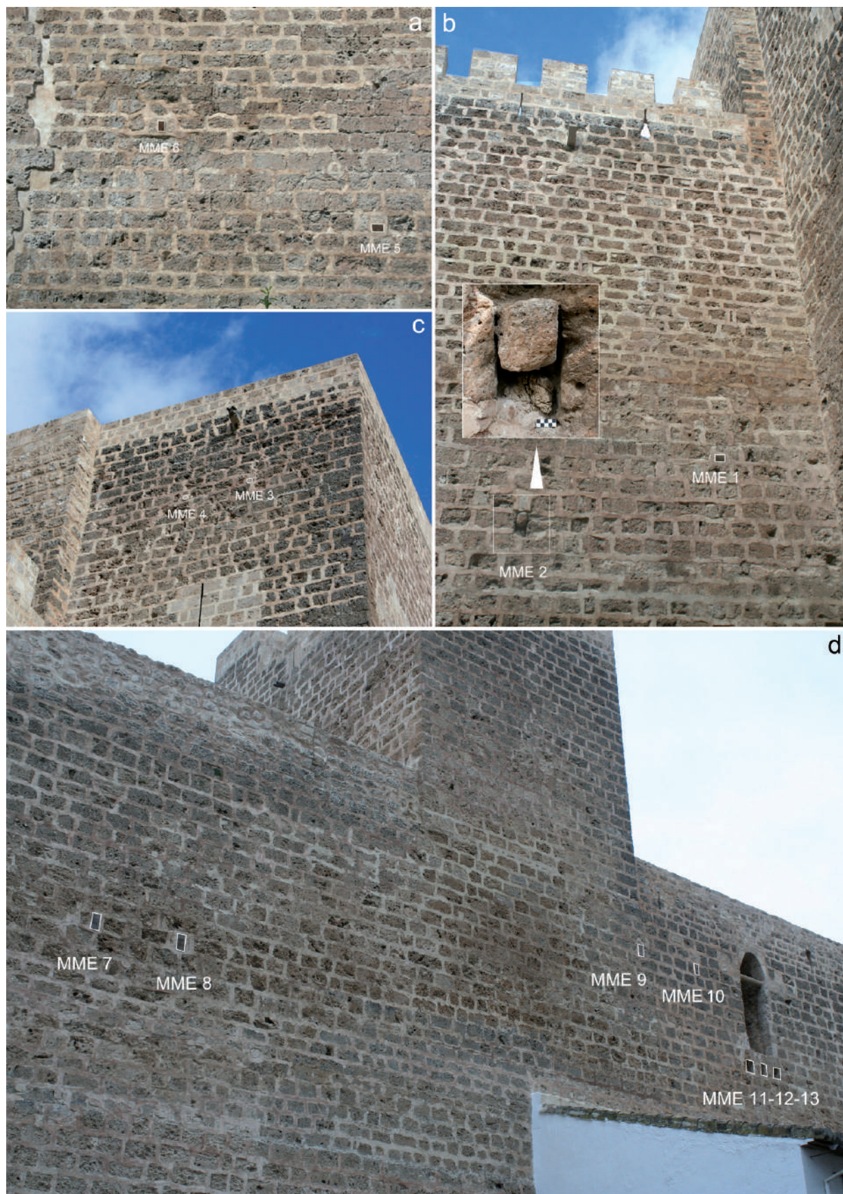
Fig. 61: Localización de MME (Mechinales y Maderas estructurales): (a) MME 5 y MME 6 [Lienzo 1, exterior]; (b) MME 1 y MME 2 [Lienzo 2, exterior]. La flecha indica un detalle de MME 2 con la madera datada por radiocarbono; (c) MME 3 y MME 4 [Torre 3, lado a]; (d) de MME 7 a MME 13 [Lienzo 2, interior; Lienzo 1, interior].
