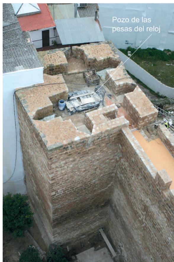
Fig. 9: Torre 1, en un momento avanzado de las obras de 2019-2020. Desmochada en el siglo XIX, conserva parte de las Cámaras de tiro y el arranque de la escalera de subida a la terraza. En el centro se abrió, en el siglo XVIII, un pozo para las pesas de un reloj público.
