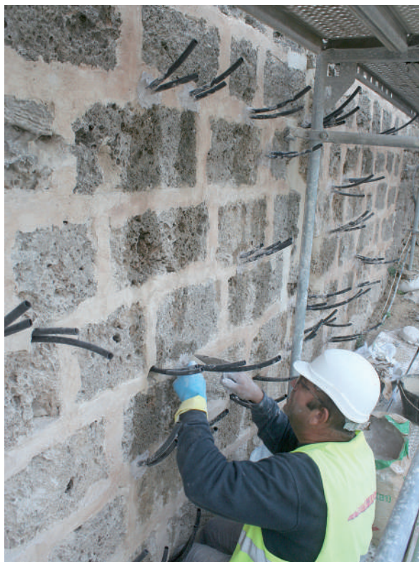
Fig. 32: Lienzo 1, interior. Ejecución de cosidos estructurales.
