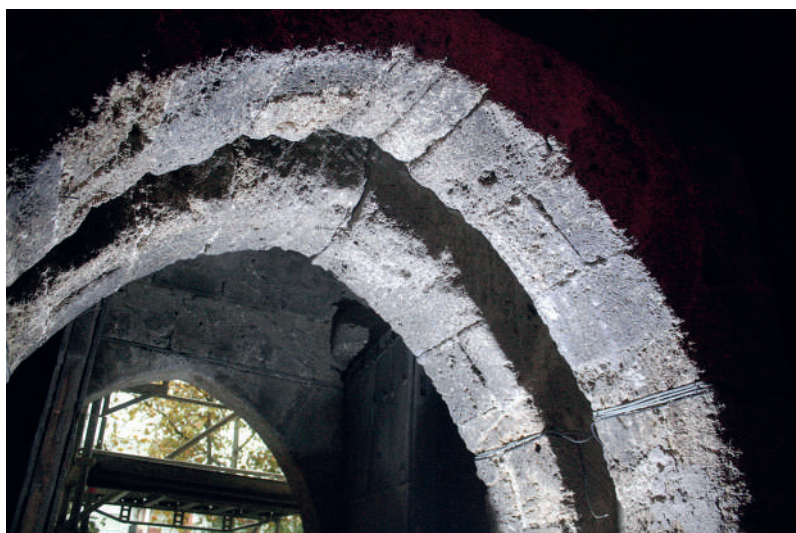
Fig. 75: Lienzo 1, puerta de entrada al castillo. Detalle de la doble arcada que alberga la mortaja del rastrillo.
