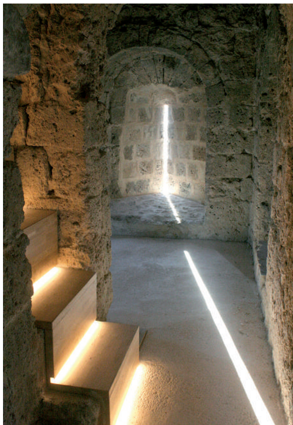
Fig. 34: Torre 3, interior. Inicio de la escalera de acceso a la terraza forrada en madera con sistema de iluminación incorporado en la línea de unión de huella y tabica. Esta iluminación artificial se combina con la natural que aportan puerta de acceso y aspilleras de las cámaras de tiro.
