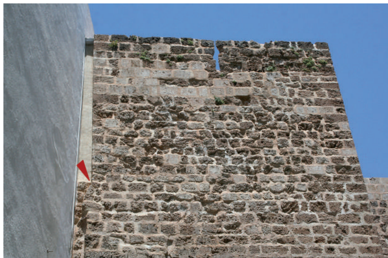
Fig. 78: Torre 1, lado b. La flecha marca la altura de la muralla de la villa bajomedieval (y de la madina islámica), actualmente desaparecida, en su enteste con la torre.
