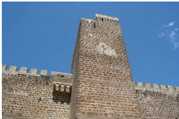
Fig. 14: Torre 2, que intercepta el paso entre los Lienzos 1 (con ladronera) y 2. Al término de los trabajos de 2019-2020.
