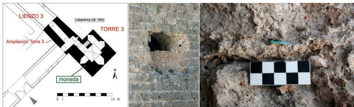
Fig. 124: Localización exacta del hallazgo del real de vellón de Enrique II en el grueso de la obra de la Torre 3. Sin el daño histórico que presentaba la aspillera de la Cámara de tiro D (foto del centro), que deja expuesto el núcleo interno de la estructura medieval, su recuperación hubiera sido prácticamente imposible.
