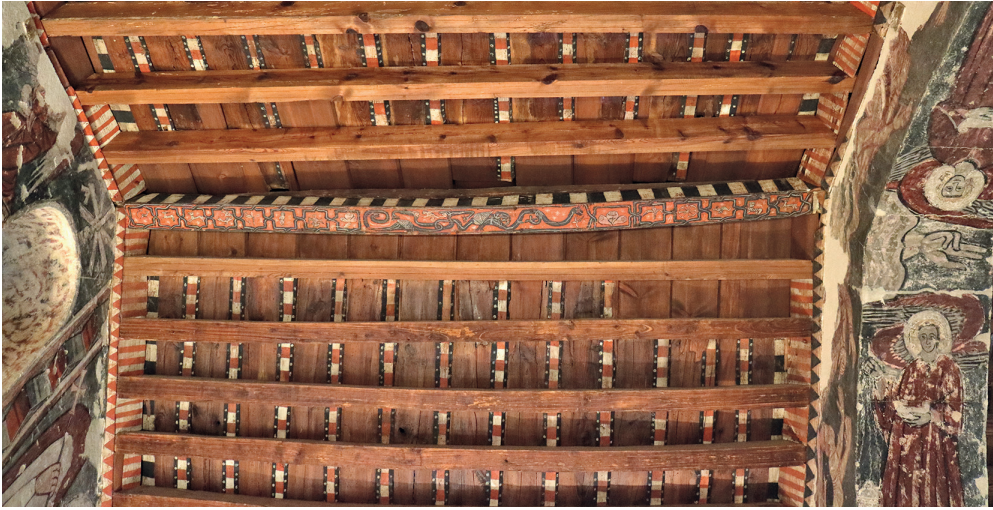
Sección oriental de la techumbre de la iglesia de San Miguel de Barluenga. Vista general. (Foto: M. a Celia Fontana Calvo)
