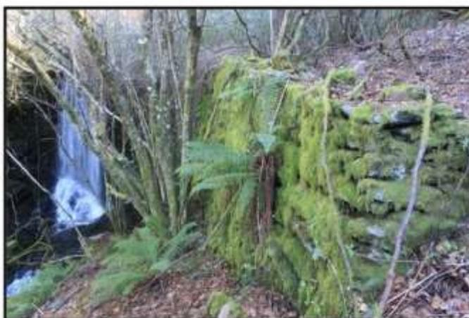
**Figura 34** – Muros de suporte de socalcos (2015).
