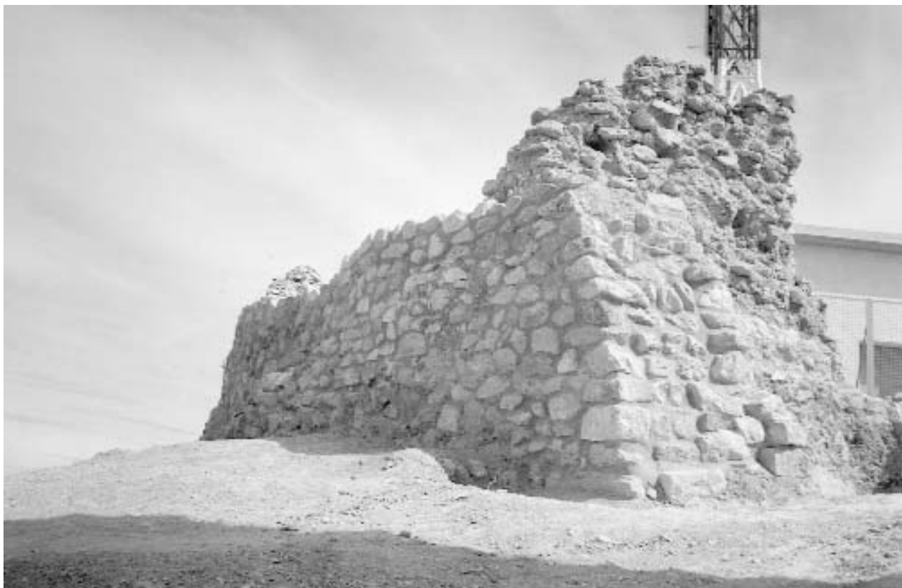
Foto 4. Rada 1995. Consolidación de la muralla.
