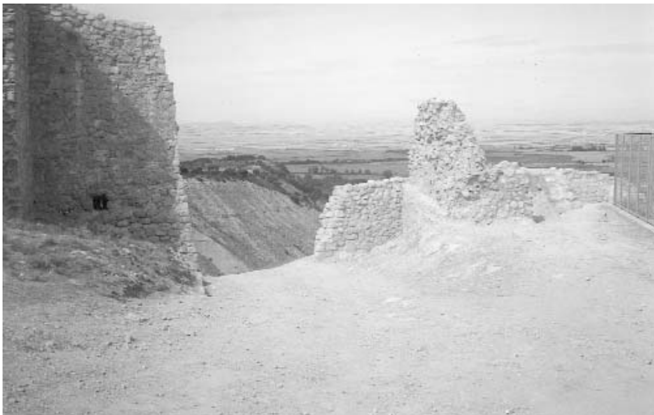
Foto 3. Rada 1995. Consolidación de la muralla.
