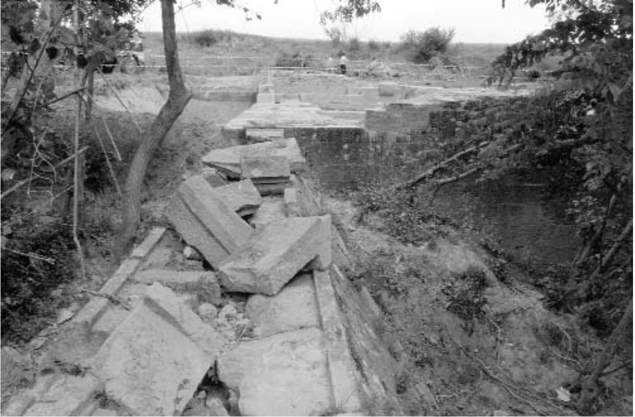
Foto 6. Presa de la Serna 94.
