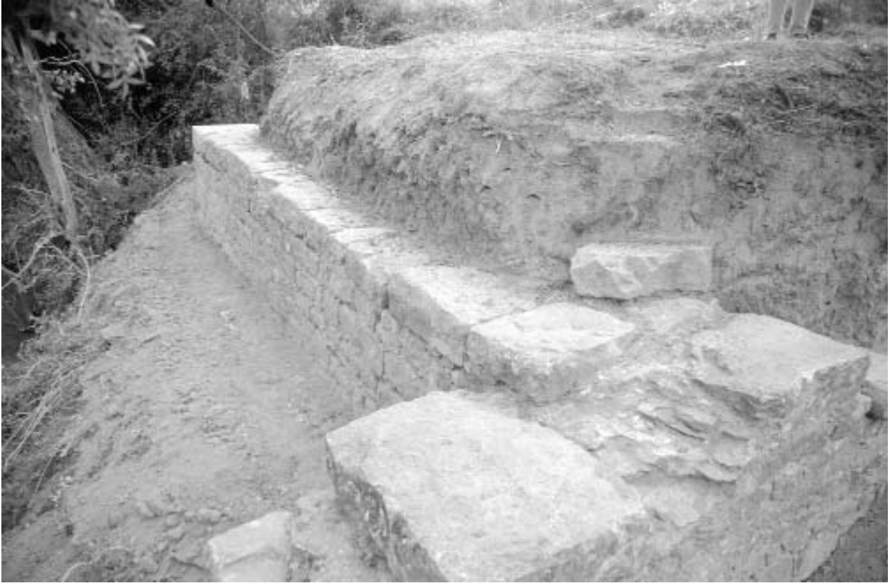
Foto 8. Presa de la Serna 94.
