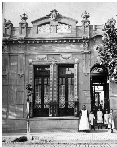
Figura 14: Casa de Casildo González. Calle San Luis 84, Mendoza. Fuente: Archivo Familia Nalda González.
