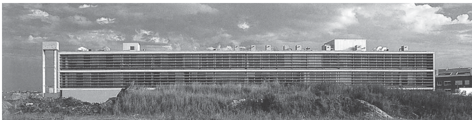
Figura 19: Faculdade de Geociências (1992). Eduardo Souto Moura, fotografia de obra. Fonte: Trigueiros, 1996.
