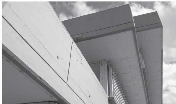
Figura 7: Detalle del hormigón visto y de los voladizos de las alas del Hotel de Turismo y Caja de Previsión Social, provincia de Formosa, Argentina, grupo URBIS (1970). Fuente: Fotografía de Ricardo Panero.
