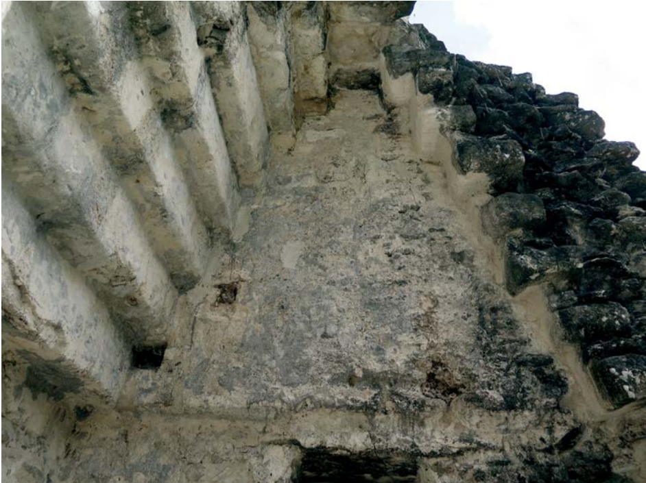
Figura 7. Bóveda de la Estructura E-X de Uaxactún (Fotografía de Laura Gilabert).
