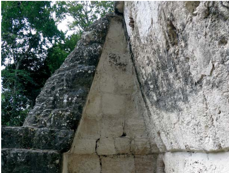
Figura 9. Bóveda con dovelas Petén en el Edificio D de Nakum (Fotografía de Laura Gilabert).
