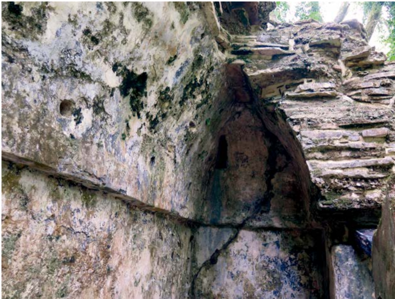
Figura 5. Bóveda del Edificio 7 de Yaxchilán (Fotografía de Laura Gilabert).
