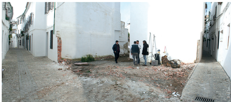
Fig.: 20: Localización del solar de c/ Real, 55 en la encrucijada marcada por las calles Real (izquierda) y Jazmines (derecha). Puede observarse la estrechez de ambos viarios, en especial el correspondiente a c/ Jazmines, cuya existencia es incompatible durante la puesta en uso de la planta completa de la vivienda andalusí documentada.
