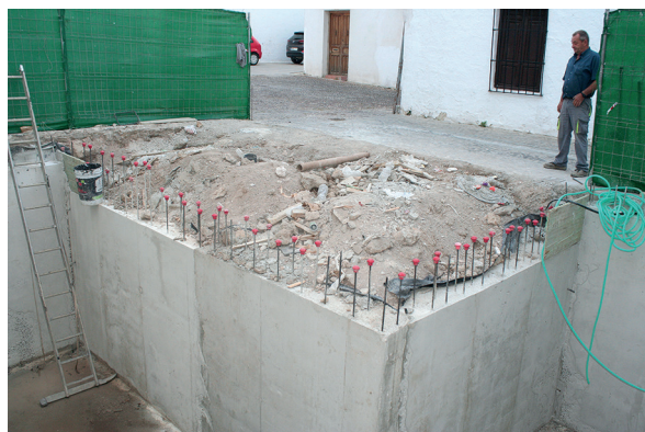
Fig. 7: Sector C antes de su limpieza y tras la sustitución de los paramentos de la bodega por encofrados.
