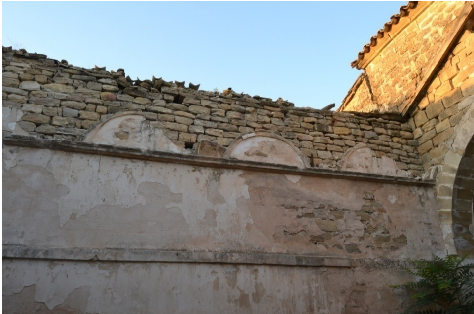
Vista del testero del evangelio. Fuente: propia.
