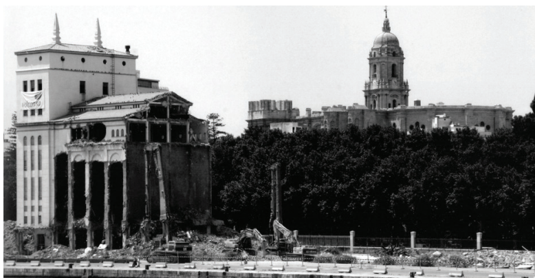
Figura 2 Demolición del Silo del puerto. 2006-05-24
