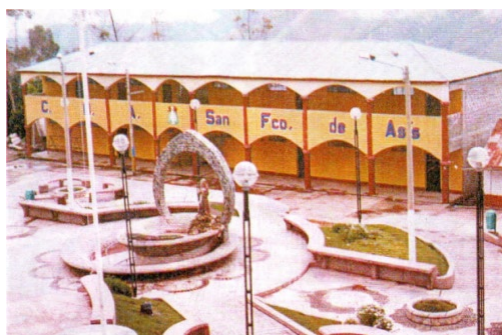
Fig. 2. Infraestructura de la Institución Educativa
